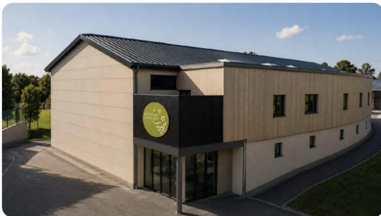
Extension du hall sportif - Valente architecture
